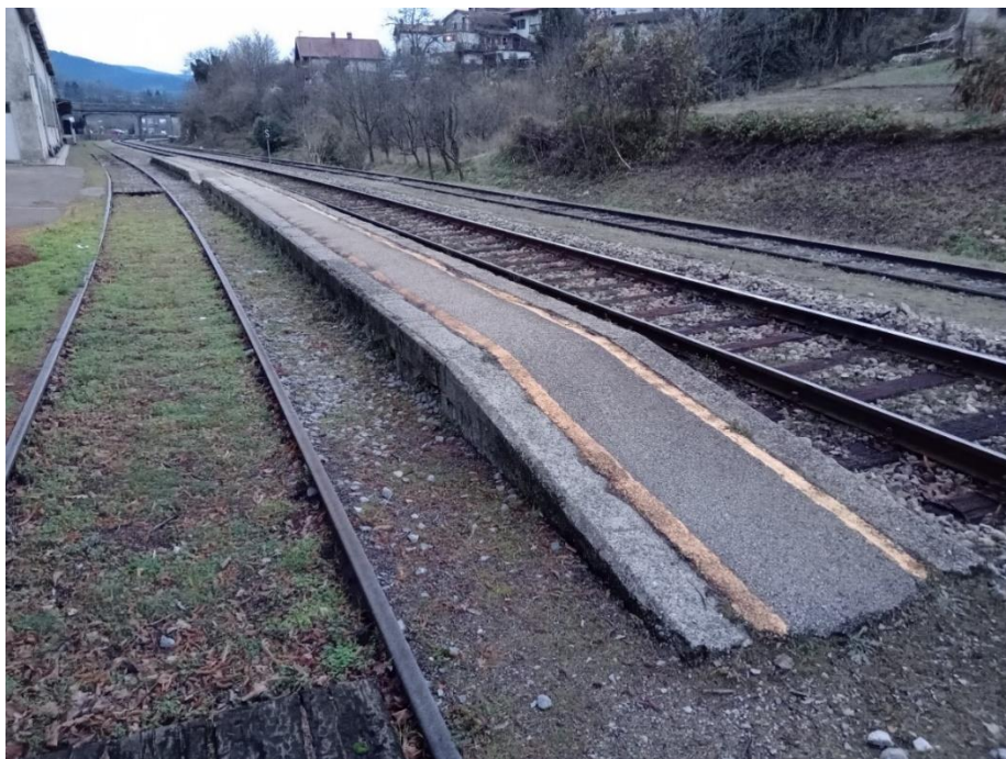
Slika 38: Peronska infrastruktura kanalske železniške postaje
