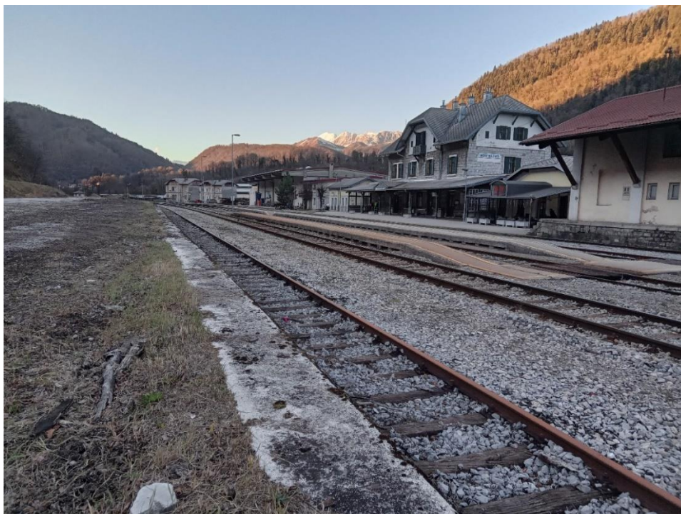
Slika 30: Železniška postaja Most na Soči s pripadajočo peronsko infrastrukturo
