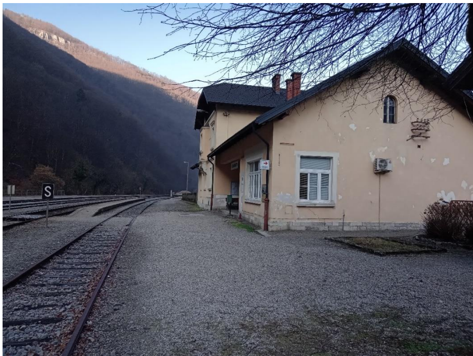
Slika 24: Postaja premore dva preozka in prenizka perona z nestabilno površino in s peskom nasut sprednji del postaje; na fotografiji je vidna tudi dotrajanost fasade
