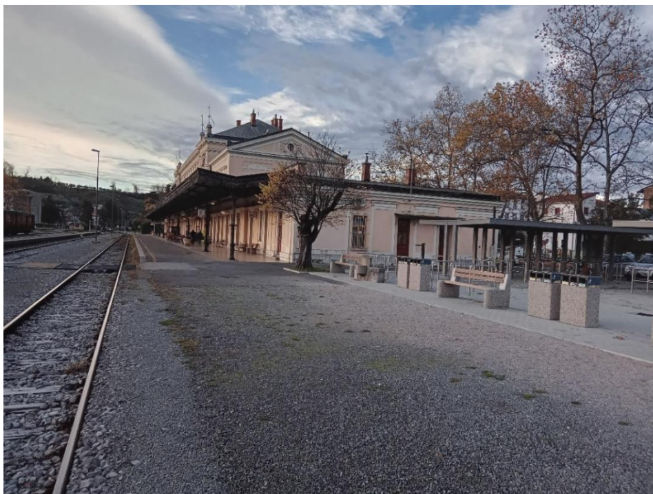
Slika 49: Prenovljene zunanje čakalne kapacitete s pripadajočim parkiriščem za kolesa
