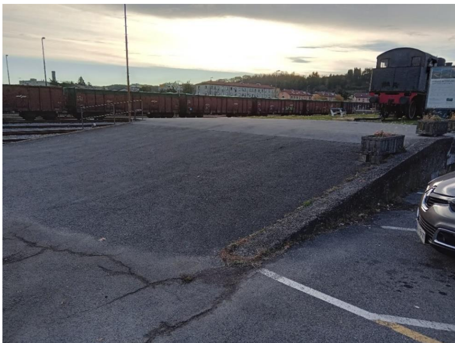
Slika 50: Izredno ozka nakladalna površina na terminalu za avtovlak
