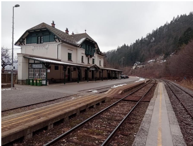
Slika 16: Železniško postajališče Bled Jezero z urejeno postajno stavbo in pripadajočo peronsko infrastrukturo
