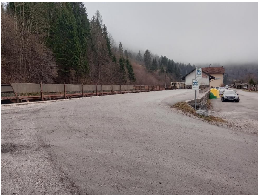
Slika 19: Terminal za avtovlak z nakladalno klančino
