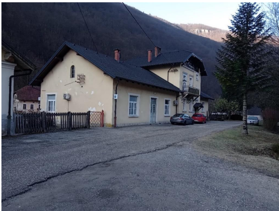
Slika 25: Zadnja stran postaje s pripadajočimi neoznačenimi parkirnimi površinami
