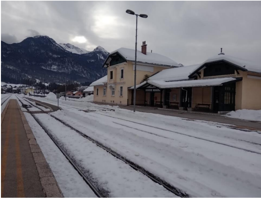
Slika 11: Železniška postaja Bohinjska Bistrica s pripadajočo peronsko infrastrukturo
