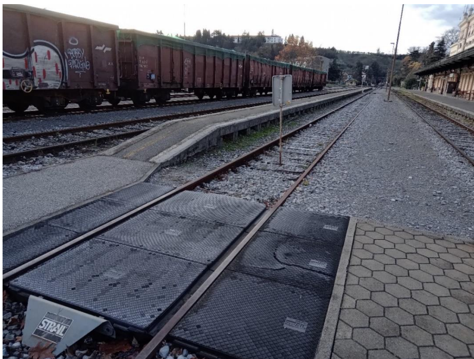
Slika 48: Neprimeren preozek in prenizek drugi peron ter tlakovan dostop preko zaprtega drugega tira
