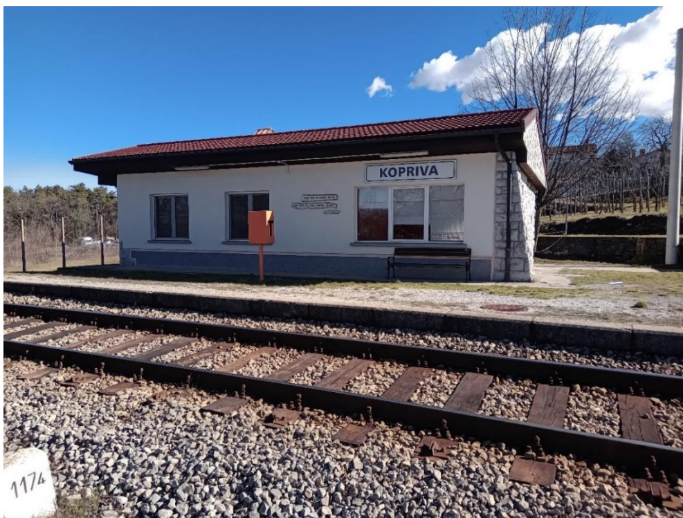
Slika 72: Urejena postajališčna zgradba z neprimerno peronsko infrastrukturo.
