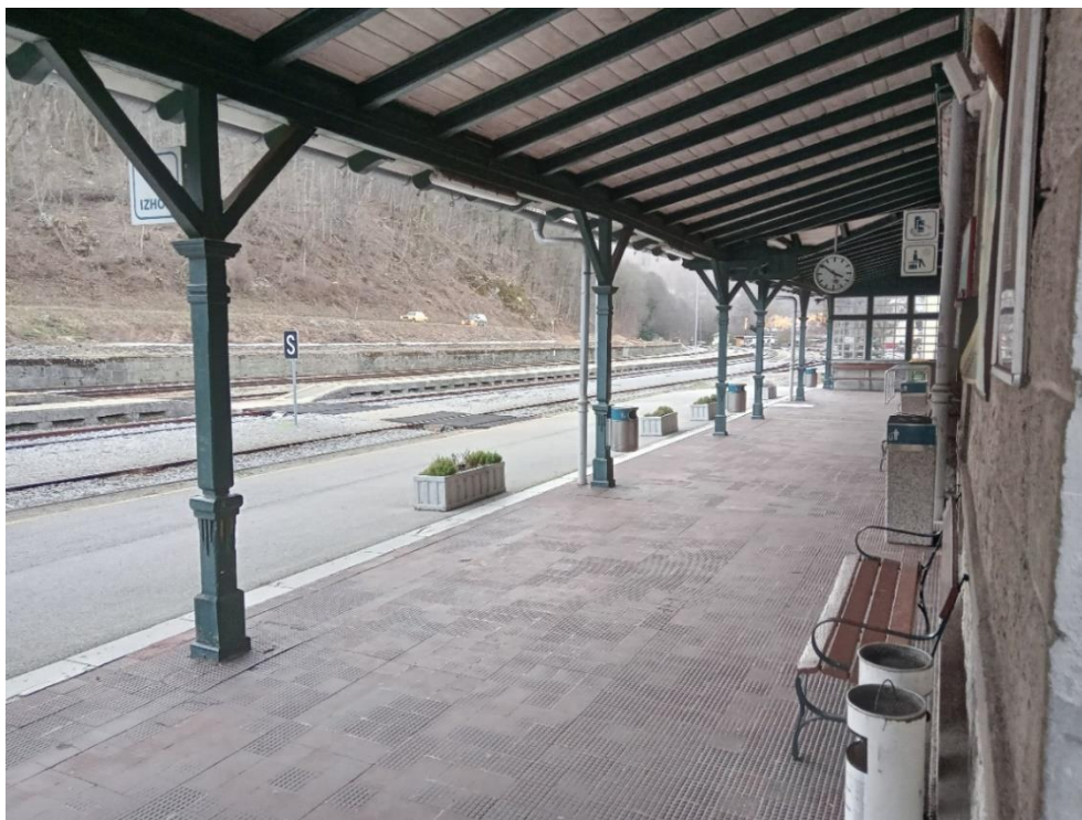
Slika 32: Z lesnim nadstreškom pokrite zunanje čakalne kapacitete
