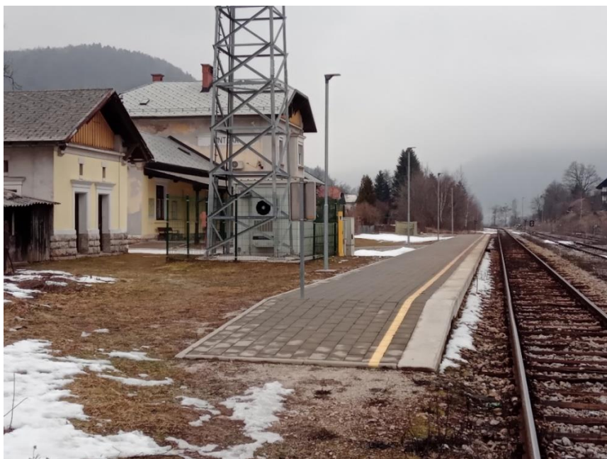
Slika 13: Prenovljen in sodobno tlakovan in osvetljen peron z utrjenim dostopom iz smeri postajališčne stavbe
