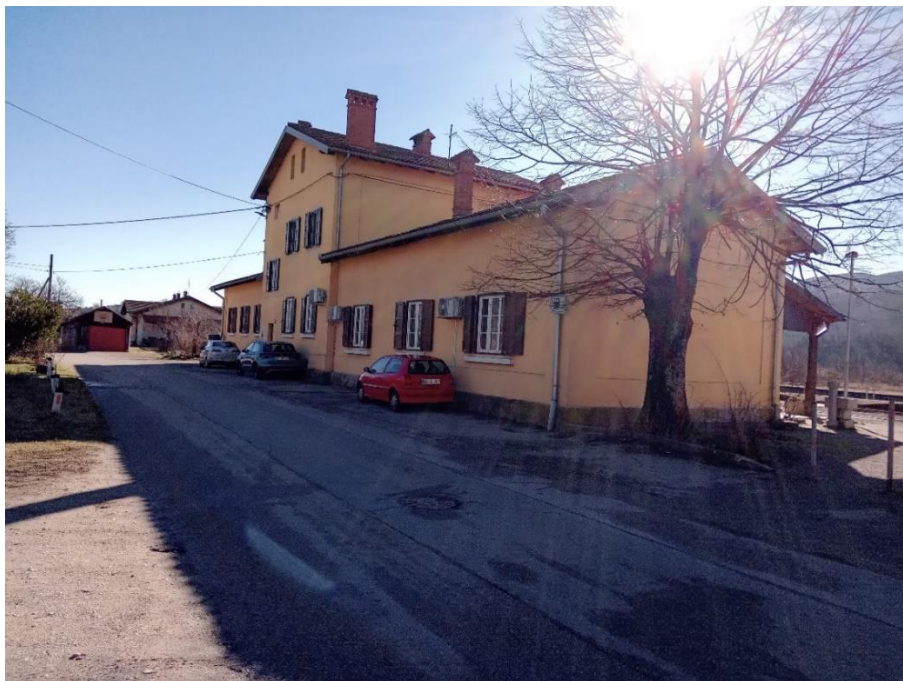
Slika 59: Zadnji del postajne stavbe z neprimernimi in neoznačenimi parkirnimi mesti
