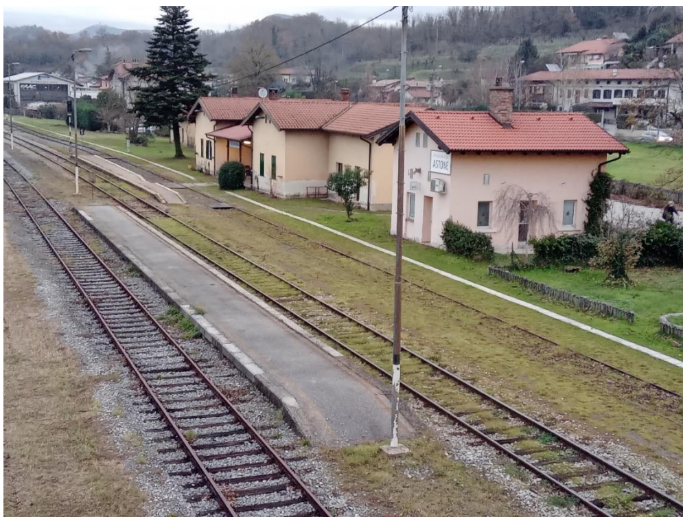
Slika 55: Železniško postajališče s pripadajočo peronsko infrastrukturo
