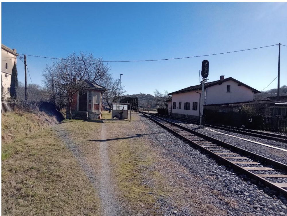
Slika 60: Kretniška postavljalnica z bližnjim svetlobnim signalom v smeri proti Sežani
