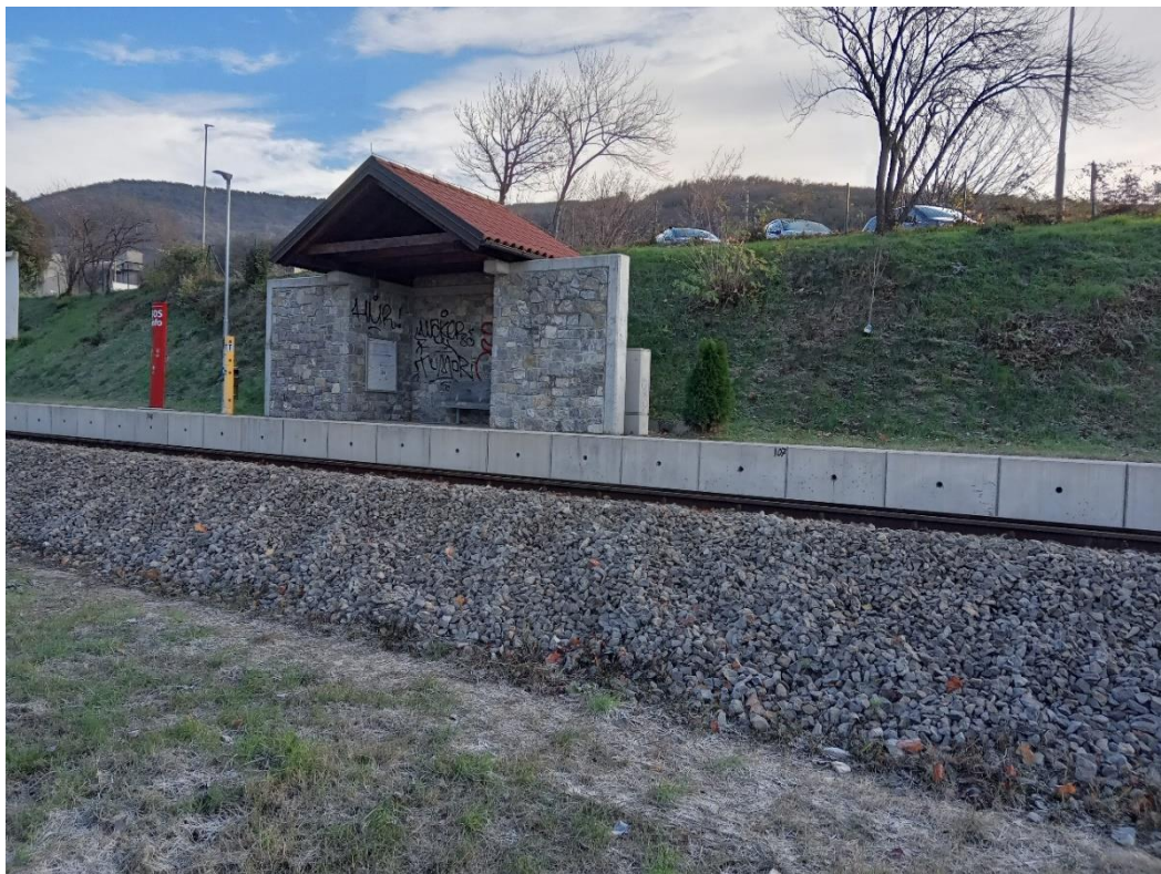
Slika 44: Moderna čakalna stavba solkanskega postajališča s pripadajočo standardno visoko in široko peronsko infrastrukturo; čakalnico že kazijo grafiti
