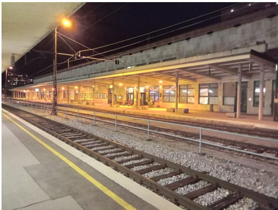
Slika 7: Sprednja stran postaje Jesenice s pokritim 1. peronom ob postajni stavbi
