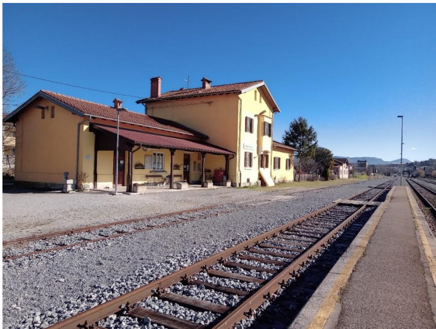
Slika 58: Sprednji del postaje z zunanjim čakalnim delom in pripadajočo peronsko infrastrukturo
