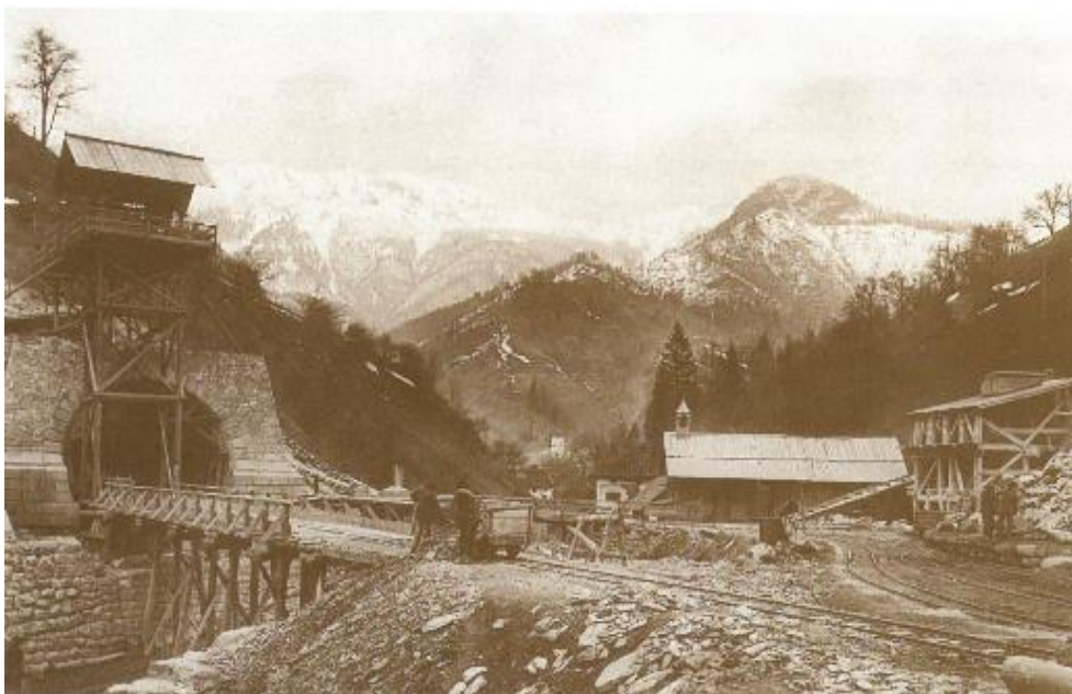
Gradbišče pri južnem portalu predora v Podbrdu (vir: Predori - iskanje svetlobe, str. 56).
