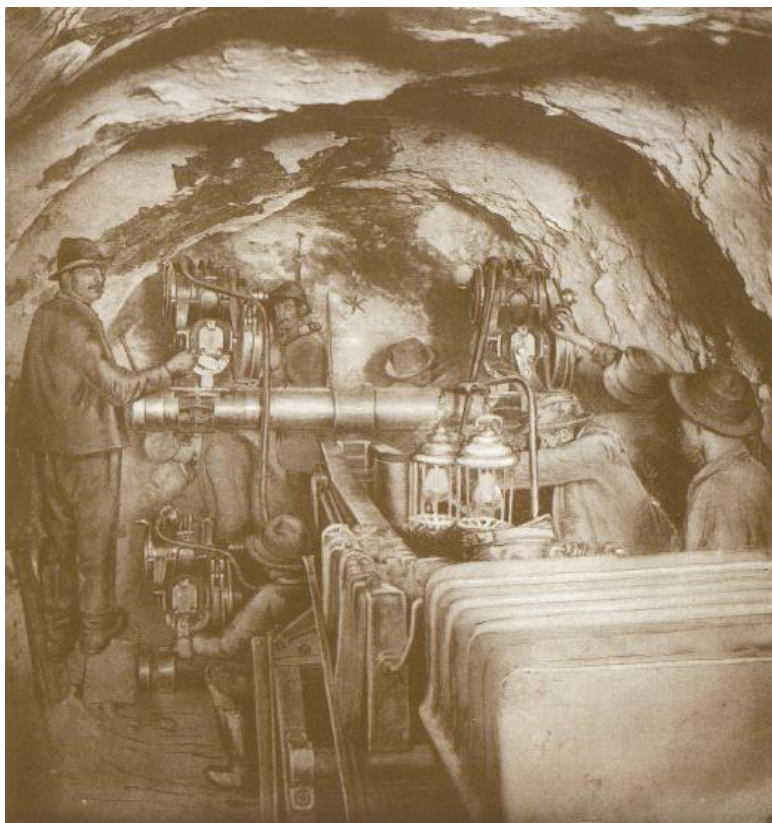
Strojno vrtanje na severni strani gradbišča je močno olajšalo naporno delo in prispevalo k hitrejšemu preboju predora (vir: Predori - iskanje svetlobe, str. 67).
