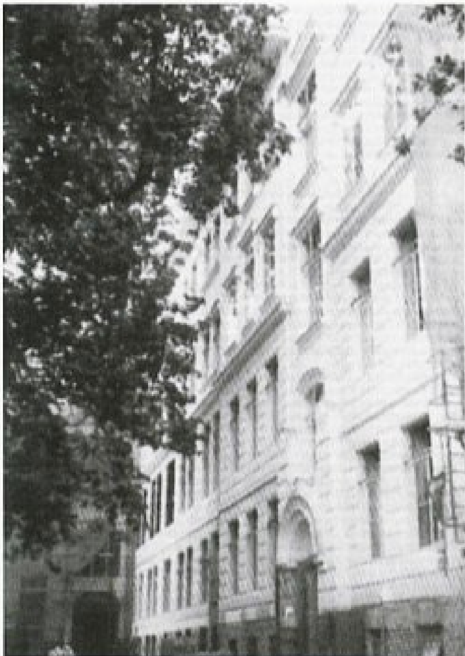
Stavba znamenite t.i. Wertheimove klinike (II. Wiener Frauenklinik), ki je svojo funkcijo opravljala od 1873 do 1993. (Foto D. Nečák)
