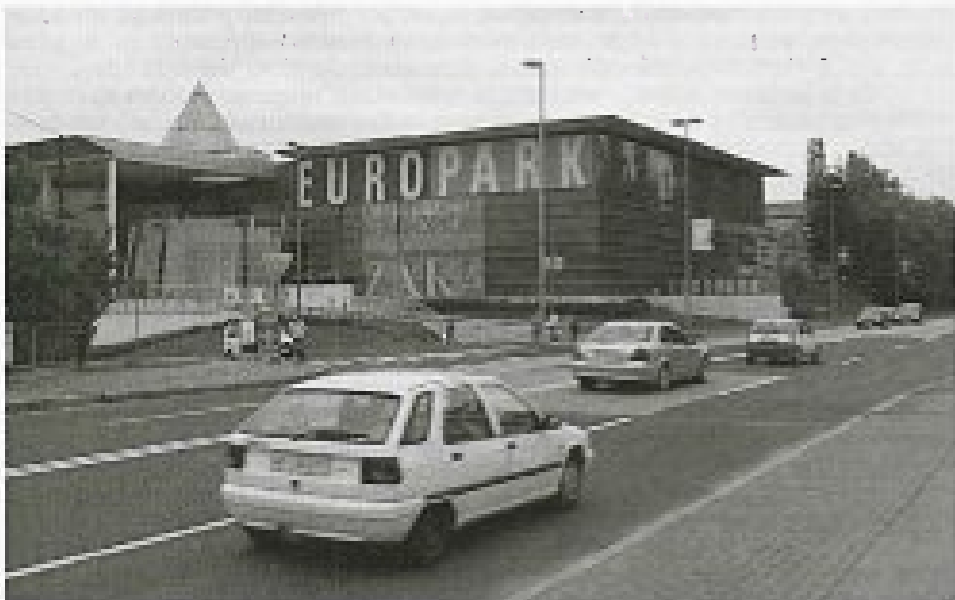
Velika označba trgovskega kompleksa Europark ob prometno obremenjeni Titovi cesti na obrežju Drave v Mariboru
