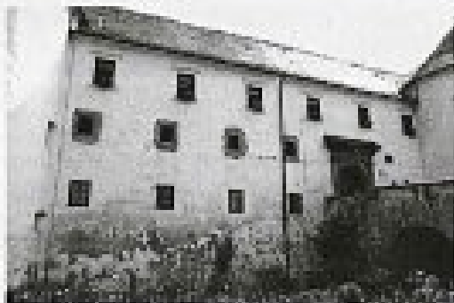
Obnova je potekala v medetaži srednjeveškega južnega trakta in jugozahodnega stolpa. (Foto Smiljan Simerl)
