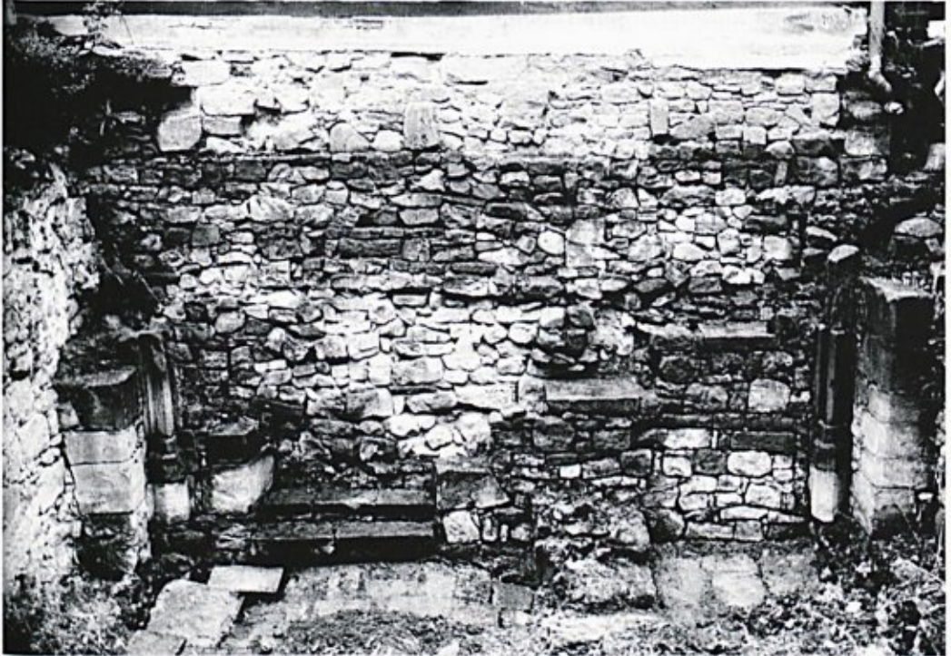
Abb. 4: Marburg, Markt 24, Fotografie der Ostmauer der Synagoge von Westen, IBD 1995; Während das rückwärtige Mauerwerk bereits die Westmauer des östlich angrenzenden Hauses darstellt, gehört das vordere Mauerwerk noch zu den Phasen II (mittlere Mauerwerkspartie) und III (Wandvorlagen und Dienste) der Synagoge.
