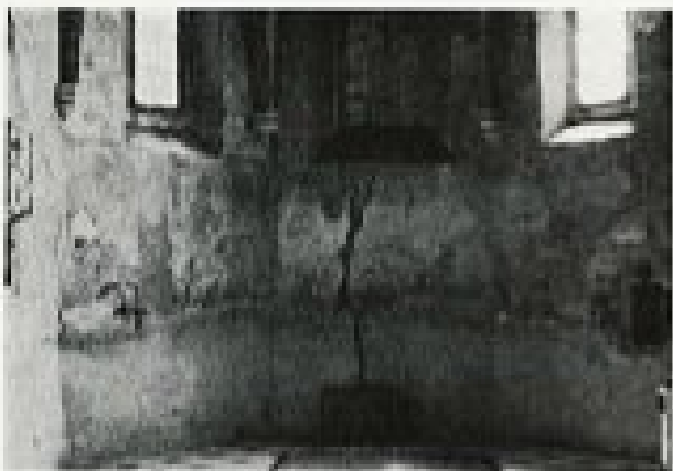
Murska Sobota — spodnji del prezbitarija stare soboške cerkve; na levi strani stenski tabernakelj, na desni vdolbina z gotško motiviko in v sredi dvojno okno s trilistnim krogovičjem v zaključni strani prezbitarija, ki je bilo leta 1955 še zazidano (foto: ing. St. Halas; stanje leta 1955).
