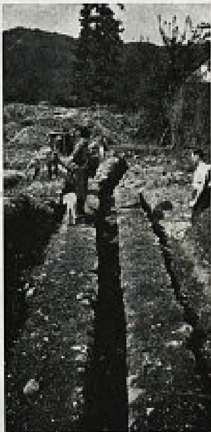
Sl. 4. Odvodni kanal med obema zgradbama
