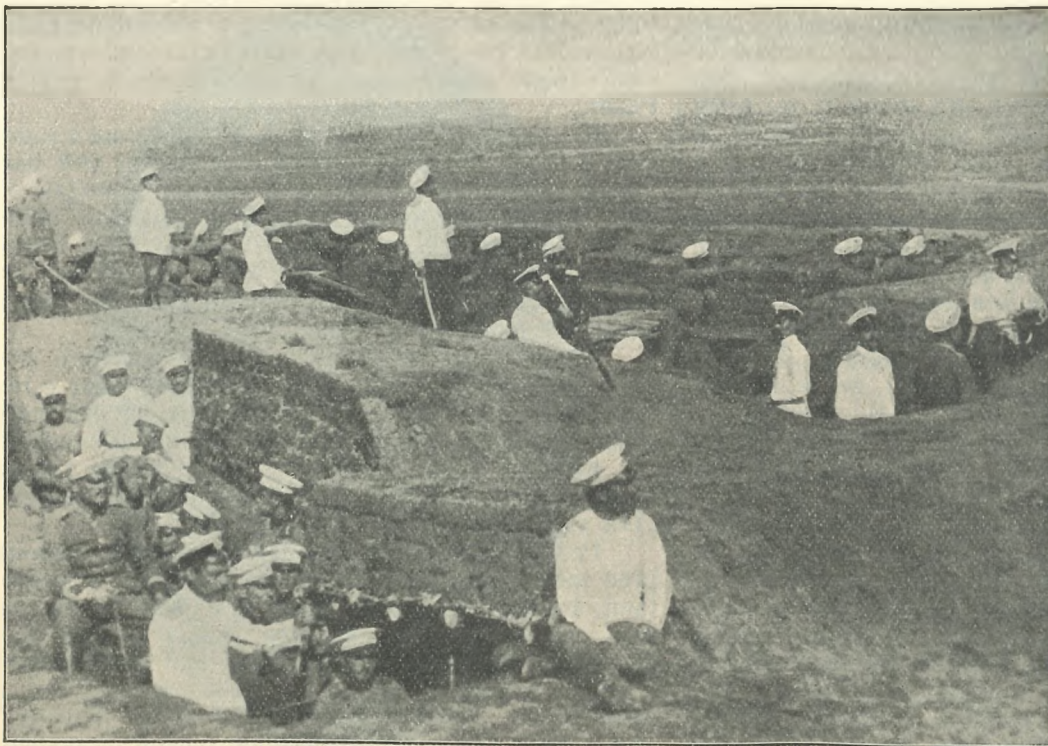
Dela na bolgarskih trdnjavah.
