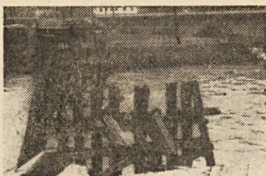
Tole je estalo od nekdanjega mosta pri Pantnerju. Končno bo treba zgraditi novega, saj je ta most nujno potreben.
