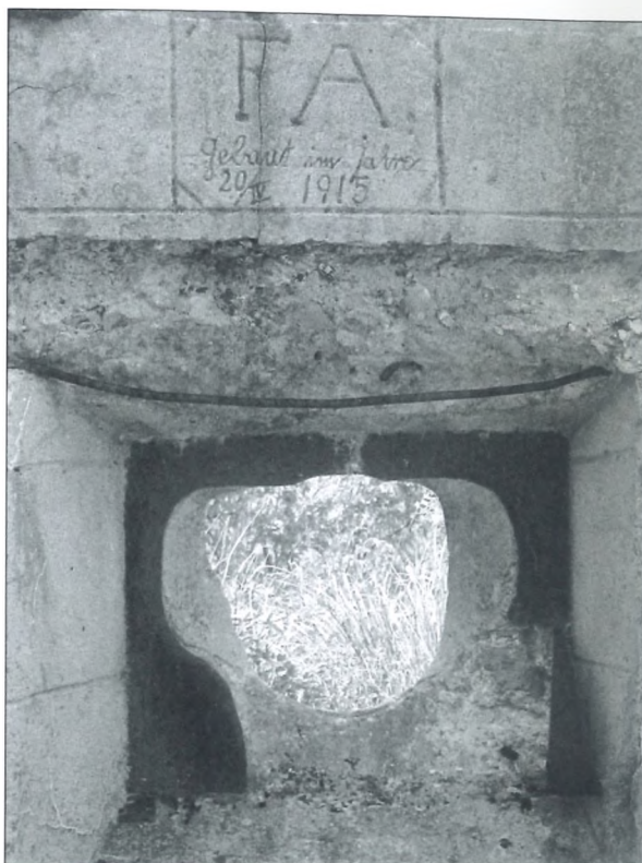
Topniška strelna lina v obrambnem sistemu Čelo na pobočju Svinjaka. Napis nad lino: Trdnjavsko topništvo, zgrajeno 20. IV. 1915 (FA, gebaut im Jahre 20/IV.1915) (foto: Mitja Juren)
