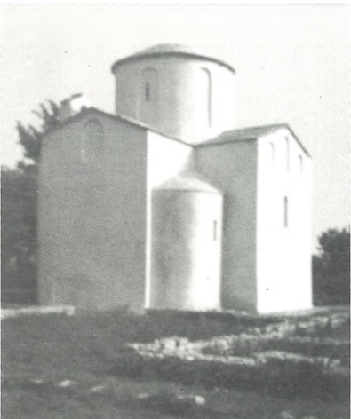
Cerkvica sv. Križa v Ninu (11. stol.). Pri Hrvatih so se pojavili prvi sakralni gradbeni spomeniki tako kmalu zato, ker so zgodaj sprejeli krščanstvo, gradnjo pa je omogočal izvrsten gradbeni material na kraškem območju. Najoriginalnejši in najzanimivejši gradbeni spomeniki so starohrvaške cerkvice svobodnih oblik. Grajene so iz grobo lomljenega kamena v posebnem slogu pod vplivom romanike, so obokane, svobodnih tlorisov so: središčni, vzdolžni in kombinacija obeh. V tistem obdobju so gradili tudi bazilike s tremi ladjami in tremi apsidami v zmanjšanem merilu (cerkvica sv. Barbare v Trogiru iz ok. leta 800).
