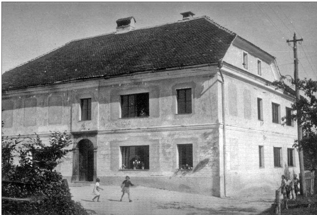
Osnovna šola z delno zazidanimi okni. Čas nastanka fotografije ni znan, verjetno je nastala v štiridesetih letih 20. stoletja, saj lahko v šolski kroniki preberemo, da so vsa okna zasteklili ob koncu omenjenega desetletja (SI ZAL LJU 460, Osnovna šola Igu).
