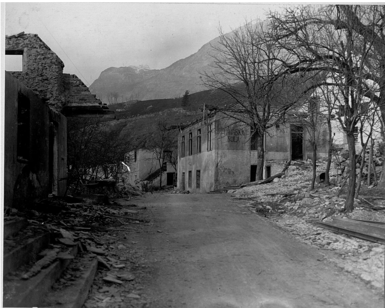
Slika 10: Stavba ljudske šole v Kalu v ruševinah. Vir: ÖNB Bildarchiv.
