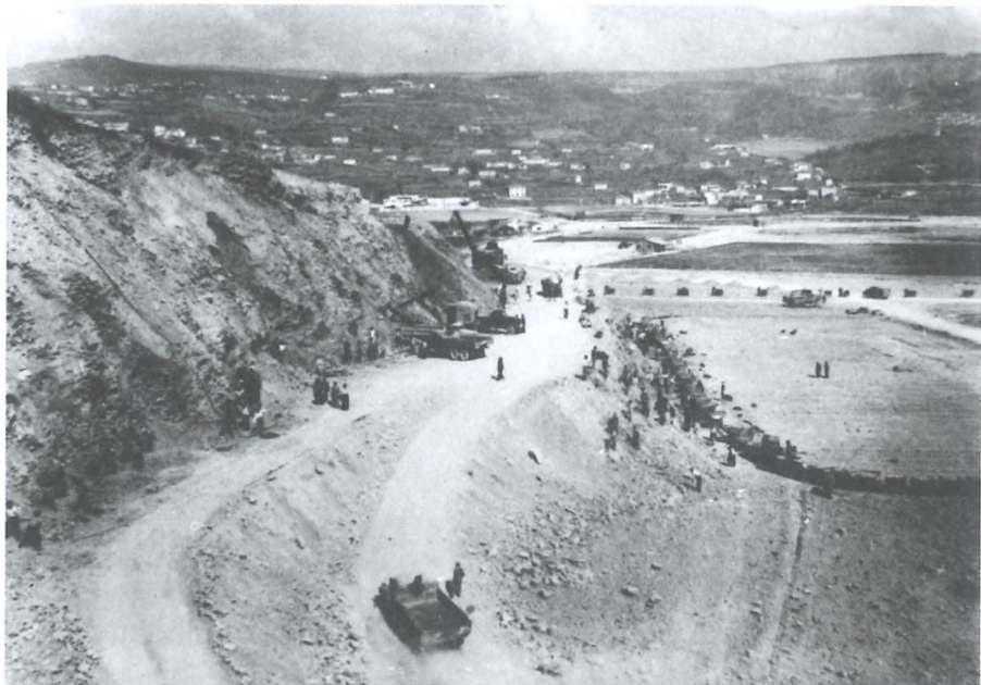
Slika 19: Gradbena dela za izgradnjo industrijske cone v Žavljah pri Trstu (NŠKZO, ZVU, Kraji, Žavlje)
