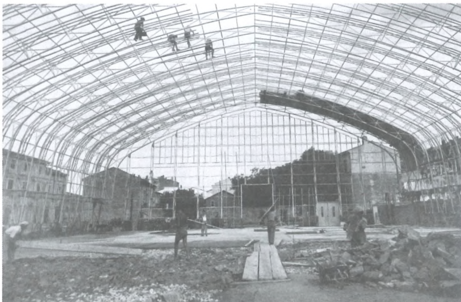
Slika 20: Gradbena dela za izgradnjo paviljona na tržaškem velesejmu (NŠKZO, ZVU, Kraji, Trst 2; zapuščina Kapelj)
