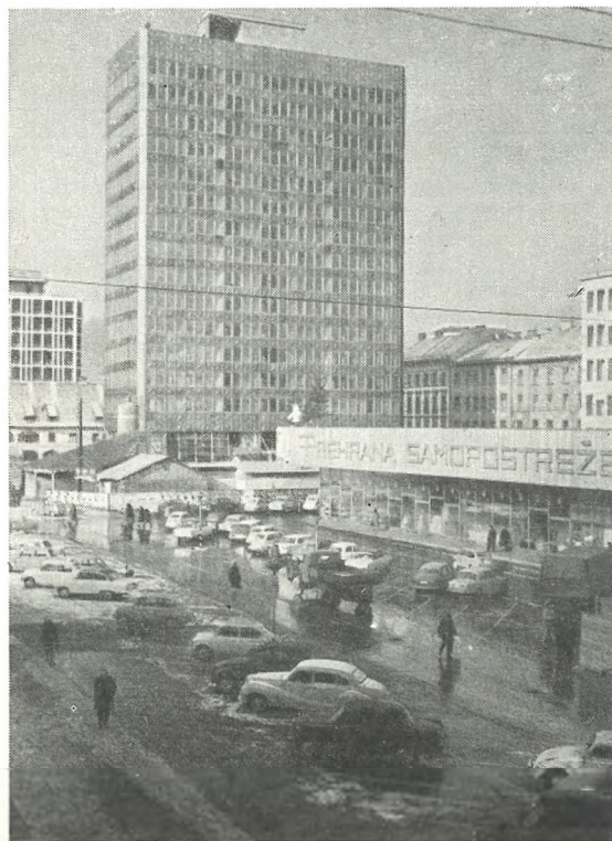
Podvoz na Celovski cesti. — Grosistično podjetje Metalka. — Gradbišče novega Trga revolucije. — Športna dvorana v parku ing. Stanka Bloudka.
