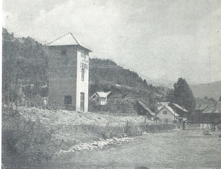
Transformator na vasi
