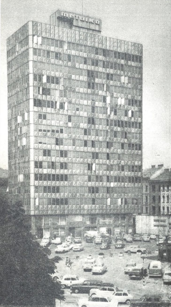
Poslovna stavba »Metalke«
