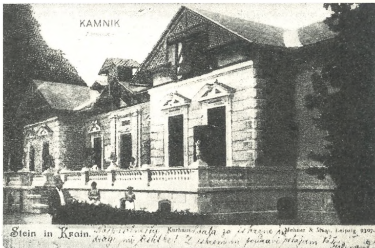
»Kopališče in vodno zdravišče Kamnik na Kranjskem«
