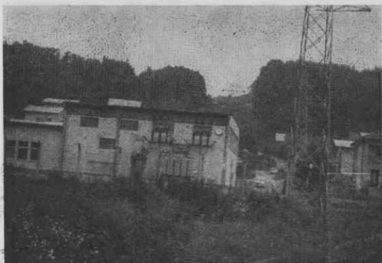
RTP (110)/35/10 kV Potoška vas v Zagorju
