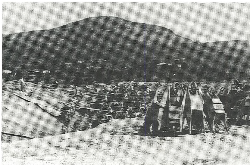
Pripravljalna dela za gradnjo Nove Gorice — regulacija struge potoka Korna, 1948. (Zbirka fotografij o gradnji Nove Gorice. Franc Mervič — Nova Gorica).
