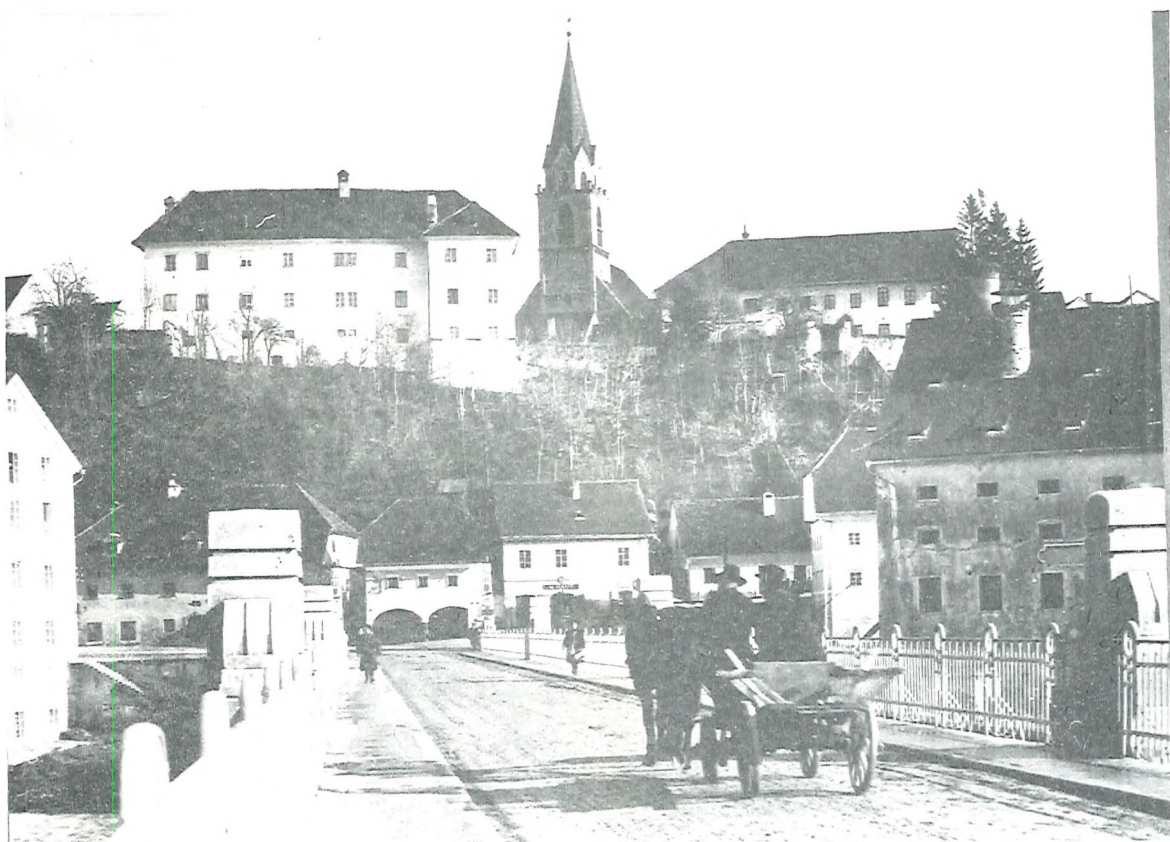
Pogled na most čez Savo v Kranju, fotografija iz časa pred prvo svetovno vojno
