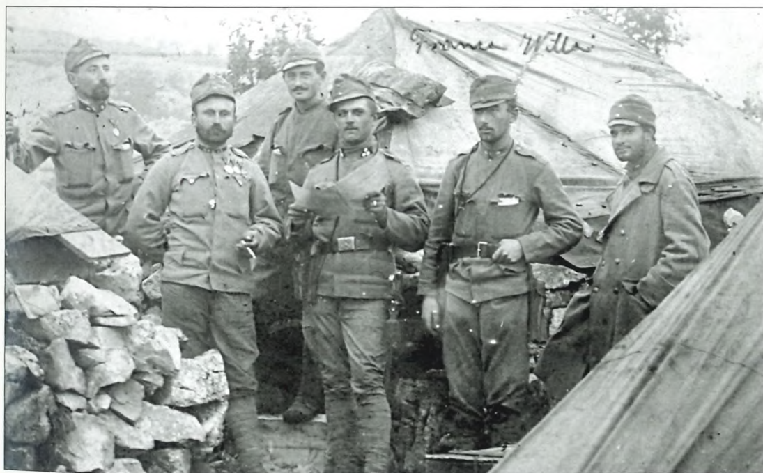
Kamniti temelj zgradbe s še platneno streho iz šotorskih kril novembra 1915, bivališče vojaka Károlyja Cservenke in njegovih tovarišev, vojakov 24. lovskega bataljona, v taboru Segeti (iz zbirke Krisztine Babos)
