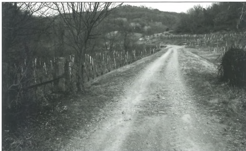
Dvignjen ravni del ceste pod Snežatnim, namenjen za železnico. Na levi se vidi mostiček z deli tračnic, vgrajenimi v ograjo. (foto Branko Morenčič)
