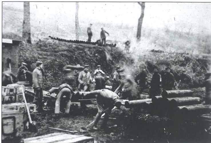
Razlaganje plinskih cevi v Vodenci (vse fotografije iz arhiva avtorja)
