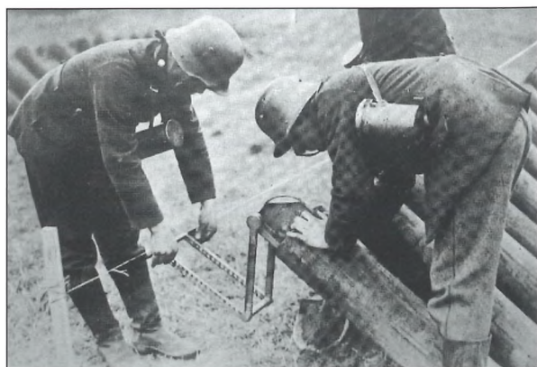
Postavljanje cevi z merilnimi napravami
