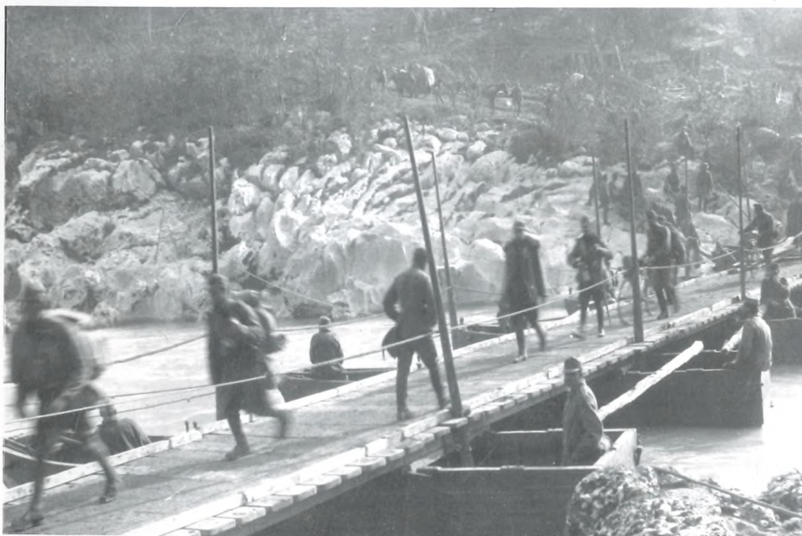
Pontonski most čez reko Sočo pod železniško postajo Avče, ki ga je postavila neka nemška enota. (zbirka: Egon Valantič)
