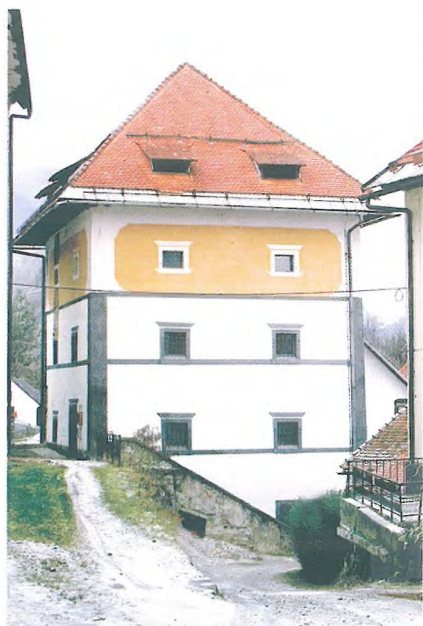
Nekdanja samostanska kašča, do nedavnega sedež enote ZAL-a v Škofji Loki
