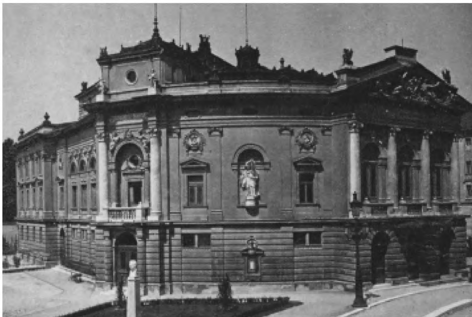
Ljubljanski oblastni odbor je moral po prevzemu nekdanjega deželnega gledališča poskrbeti za vzdrževalna dela v njem
