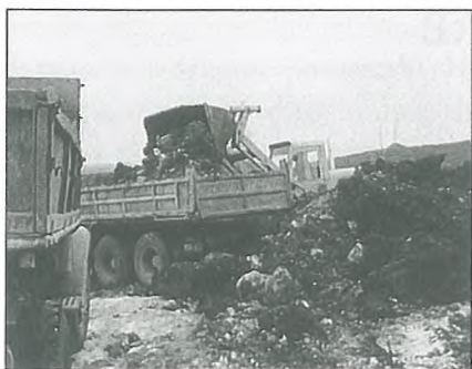
Začetek gradnje avtoceste Vrhnika–Postojna, maj 1970
