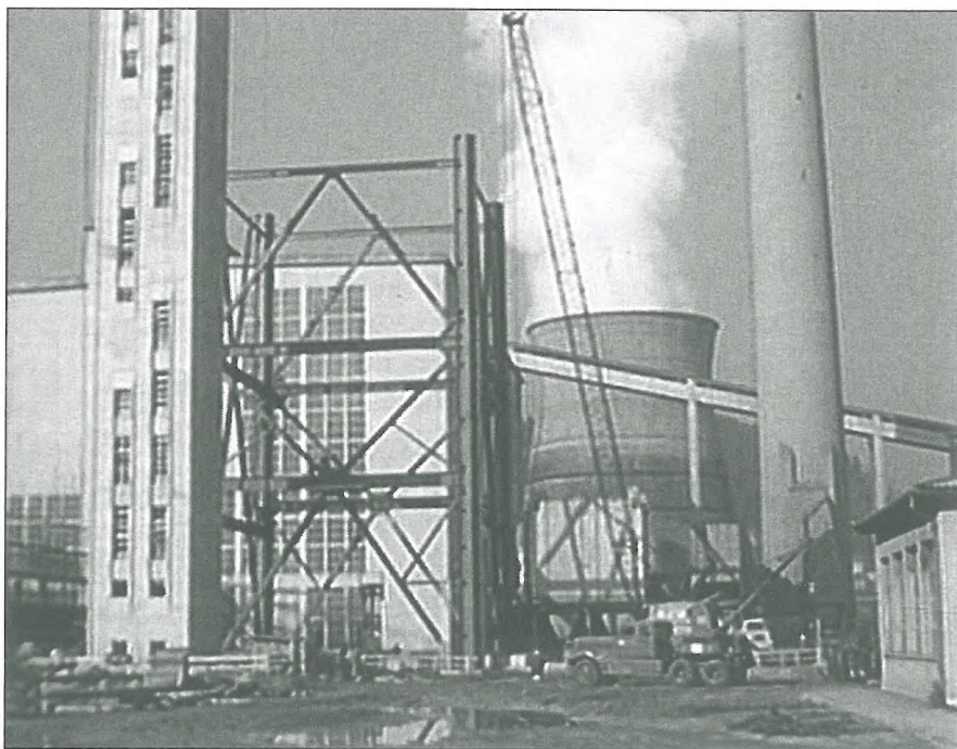
Gradnja termoelektrarne Šoštanj, november 1971
