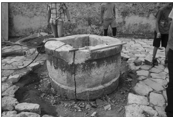
Avgust 2006. Kamniti oklep čaka, da ga dvignejo na izravnano površino tlaka, očistijo in pokrpajo. Na zgornjem robu je lepo viden odškrnjen del, kjer je bila nameščena ročna črpalka (foto: E. Belingar, 2006).
