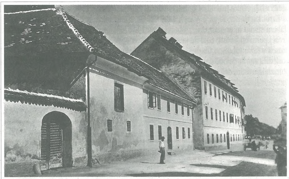
Stavba nekdanje ubožnice na Karlovški cesti 5, pred 1895 (ZAL, SI ZAL LJU 342, a. e. A1/ 206).
