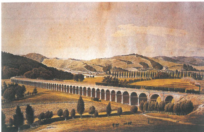
Pesniški viadukt je predstavljal enega najzahtevnejših gradbenih podvigov na progi južne železnice med Gradcem in Mariborom (F. Jungbluth, akvarel).
