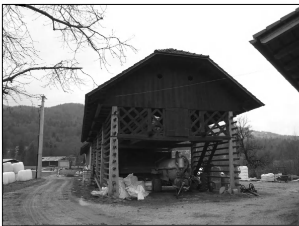
Novi toplar se podaljšuje v pokrit koritasti silos (foto: V. Hazler, 2009)
