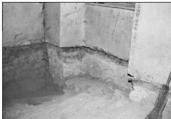
Po odstranjenem polnilu na kletnih obokih severnega trakta je viden prvotni nivo prostorov in na stenah izvirna poslikava, ki imitira marmor (foto: Nika Leben).
