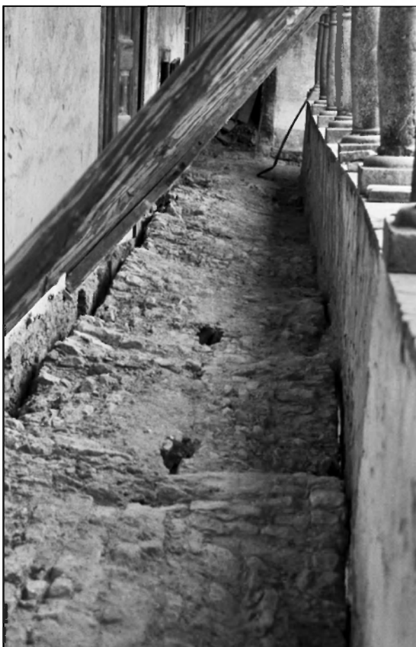
Arkadni hodnik z očiščenimi oboki; viden je odmik zidov od stene (fototeka ZVKDS, OE Kranj).
