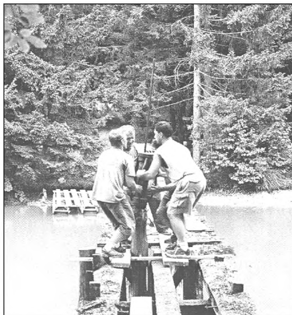
Pri obnovi mostu na 3. ribniku so delavci zabijali pilote s 100 kilogramskim "norcem" (foto: Franci Jagodic)
