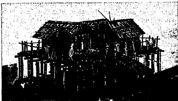
Mostiščarska stavba na kolen na Ljubljanskem barju, rekonstrukcija
